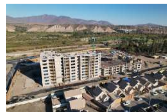
Obras de Aires del Limarí, Ovalle.
